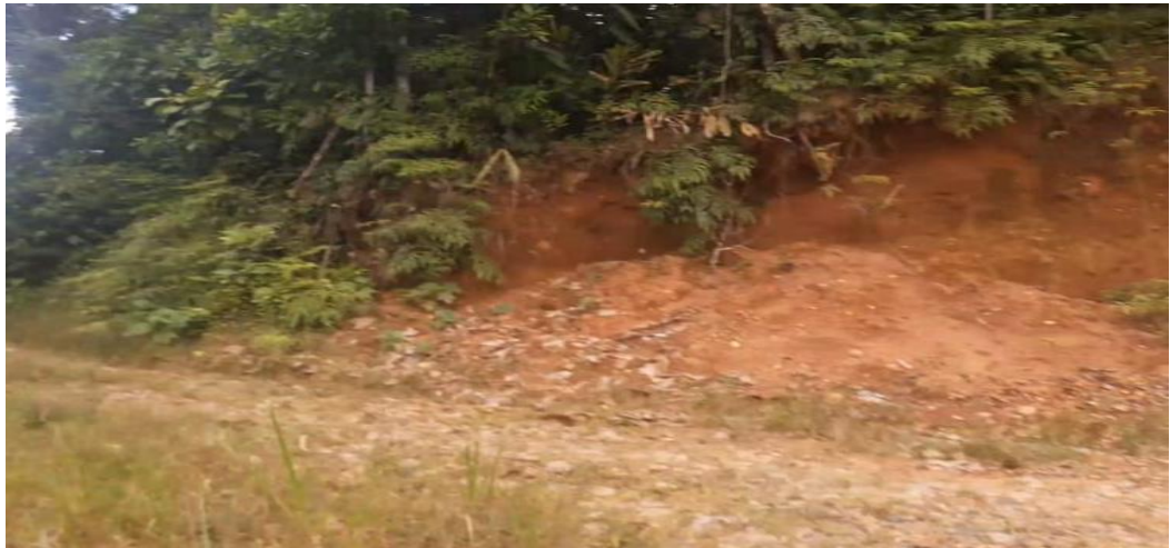
Imagen 11 Riesgo natural por deslizamientos de tierra
